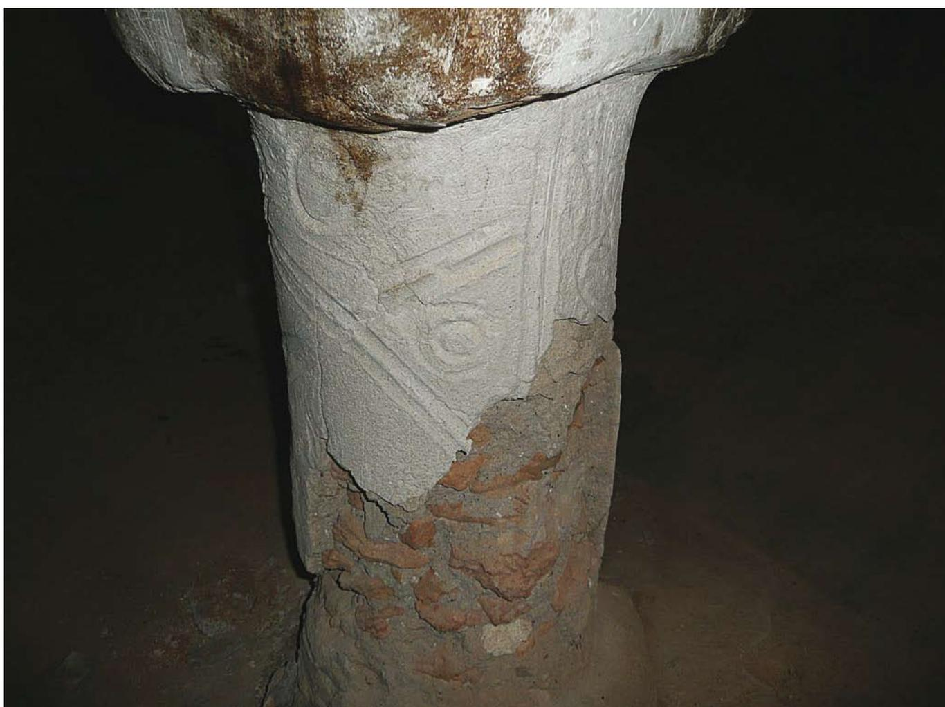
Fig. 13 - Particolare di una colonna con incisa decorazione geometrica. Notare sotto lo strato di gesso il materiale di costruzione della colonna (foto F. dell'Aquila).
